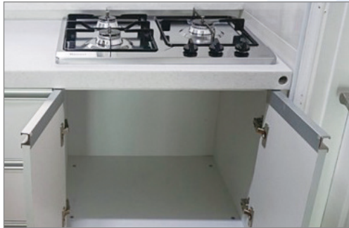
빌트인 연소기 하부장 여닫이 문을 열어 육안점검 및 가스누출 검지가 가능한 경우
