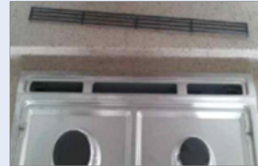
배기그릴 제거 후 육안점검 및 가스누출 검지가 가능한 경우
