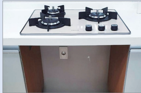
개방된 하부장에 점검구를 시공하여 육안점검 및 가스누출 점검이 가능한 경우
